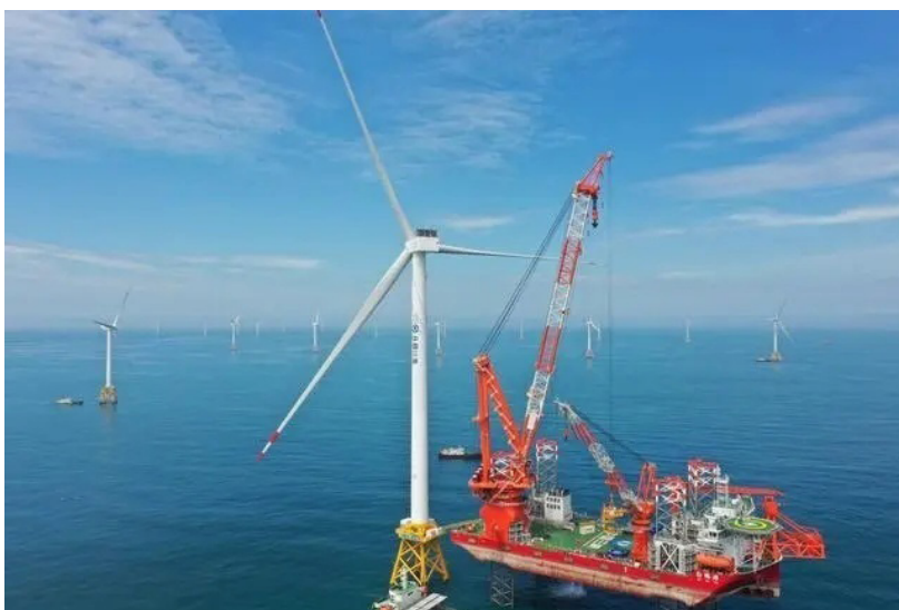
图 5.3-2 全球首台 16 兆瓦海上风电机组吊装现场 ①
