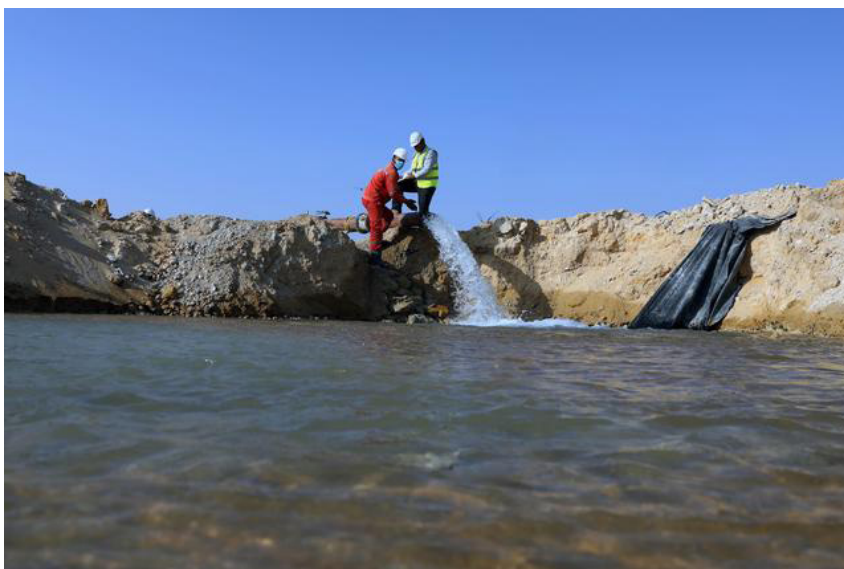
图 1.3-5 中国中曼石油埃及分公司钻井现场
