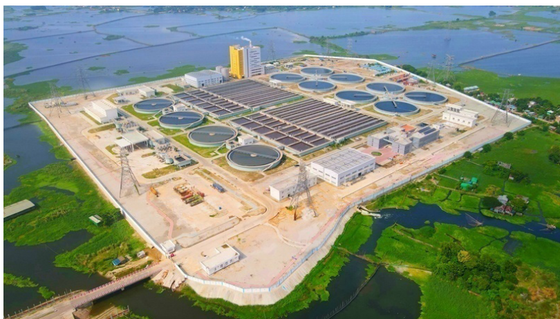
图 5.3-4 中国电建集团在孟加拉建设的达舍尔甘地污水处理厂 ③
